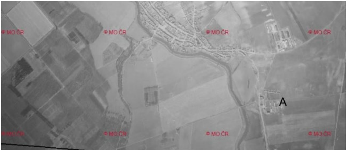
Obr. 40: Kontury bývalé železniční tratě již po vytrhání kolejí (není viditelné) v roce 1968 [28]
